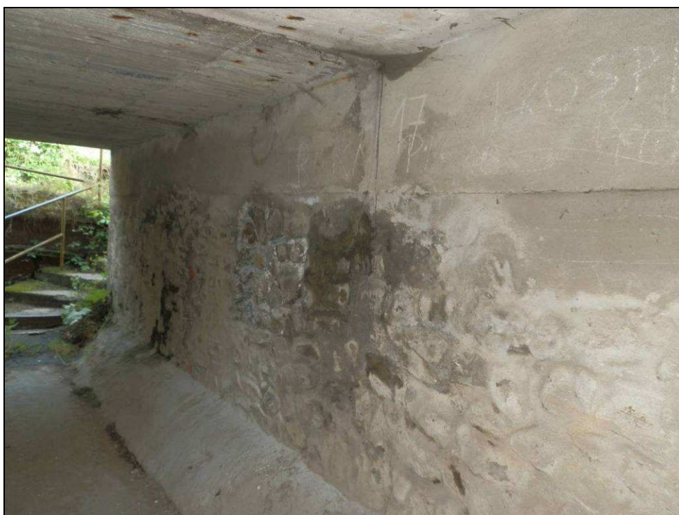
Obr. č. 4 - celkový pohled na opěru Praha. Uprostřed opěry je málo patrná pracovní spára po rozšíření trati při zdvoukolejnění. V těchto místech dochází k průsakům jak spárou v opěře, tak dilatační spárou v NK
