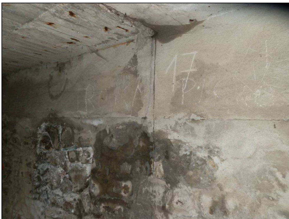
Obr. č. 5 - detailní pohled na spáru v opěře Plzeň se záteky.
