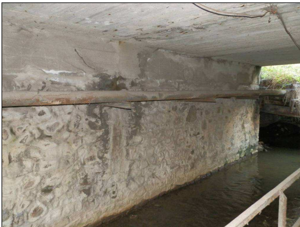
Obr. č. 3 - celkový pohled na opěru Praha. Uprostřed opěry je málo patrná pracovní spára po rozšíření trati při zdvoukolejnění.
